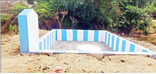
మురుగుకాల్వ నీరు చేరేవద్ద ఏర్పాటు చేసిన ఇంకుడు గుంత
